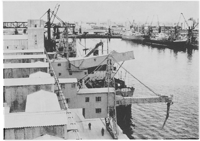
Abbildung 9. Auf dem Phosphatquai im Hafen von Casablanca. Blick vom Lagerhaus auf zwei Phosphatdampfer, die gerade beladen werden. Im Vordergrund eine unbenutzte Anlage. Photo Verfasser
