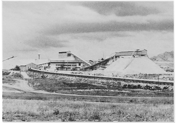
Abbildung 6. Wasch- und Zentrifugieranlagen von Kerkour-Rih. Über lange Transportbänder wandern die Phosphate von einer Verarbeitungsstufe zur andern. Photo Verfasser
