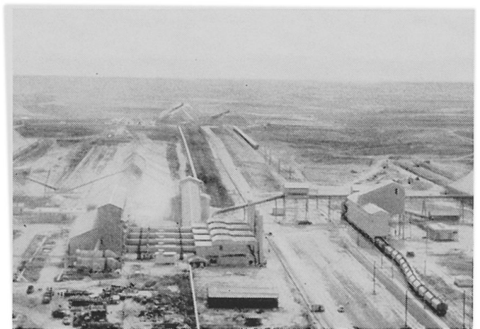
Abbildung 7. Trocknungsöfen bei Beni-Idir. Von den offenen Lagern (hinter den röhrenförmigen Öfen vorn links) gelangen die Phosphate in die Öfen und von dort in die Silos (ganz rechts im Bild). Rechts im Vordergrund wird ein Phosphatzug beladen. Photo O.C.P.
